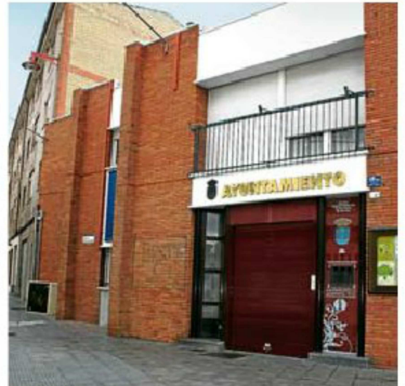
La antigua Casa Consistorial se acondicionará como cuartel de la Policía Local. /ENE
